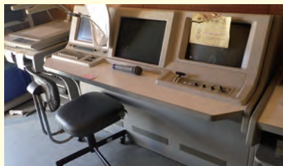
学校管理運営事業 学校施設修繕費 吉川小学校放送設備
