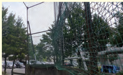
学校管理運営事業 学校施設修繕費 旭小学校バックネット修繕
