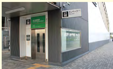
道路管理事業 土木費 吉川美南駅エレベーター2基修繕費
