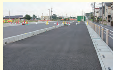
道路改良事業 道路改良工事費 市道2-422側溝整備費等「栄町3区内」
