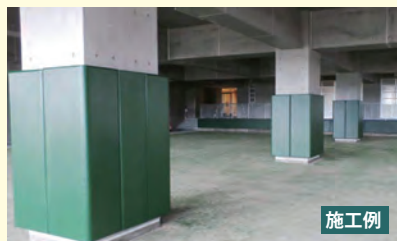
学校管理運営事業 学校施設修繕費 美南小学校体育館前校舎1階 外部柱25箇所
