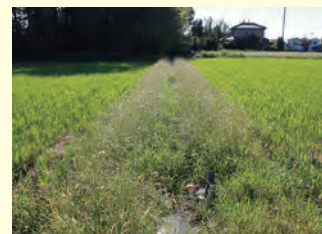
用排水路整備事業 半割地区用排水路工事等。 1100万円
