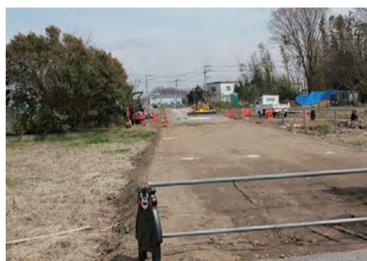
越谷吉川線地盤改良工事 中井3丁目付近
