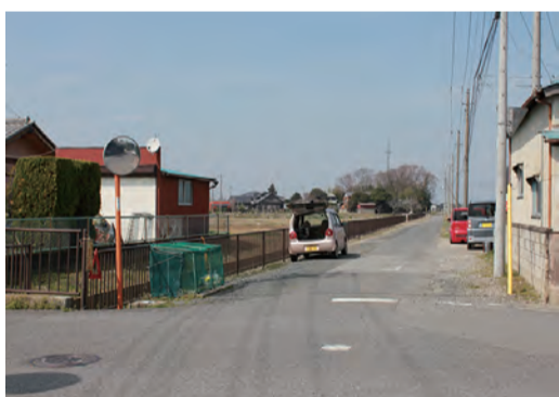
市道1-111号線舗装補修工事 八子新田地内
