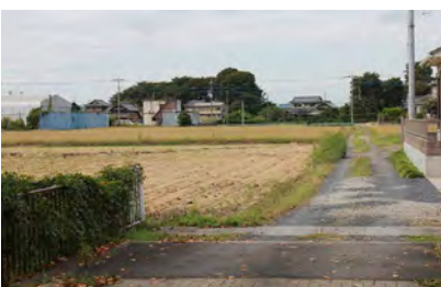
きよみ野4丁目北側川藤内新設道路
