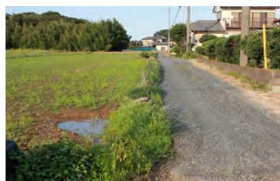
須賀集会所南西方面新設道路
