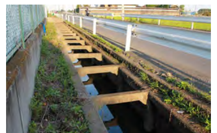
旧第二学校給食センター跡地南側歩道整備
